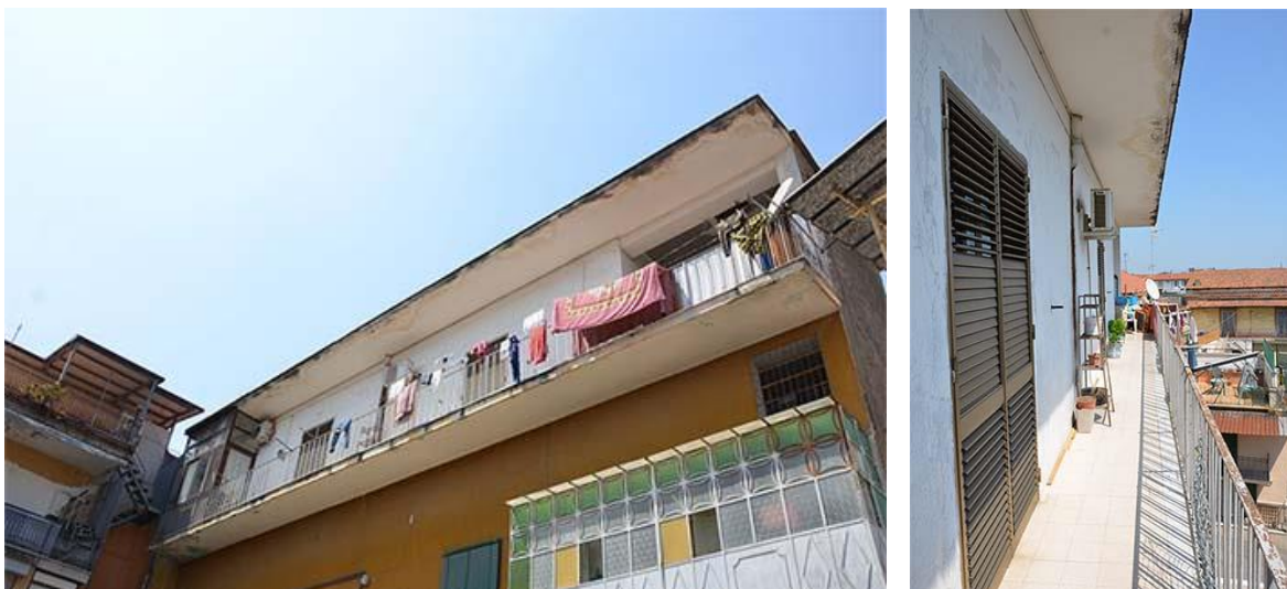
_ballatoio di ingresso
