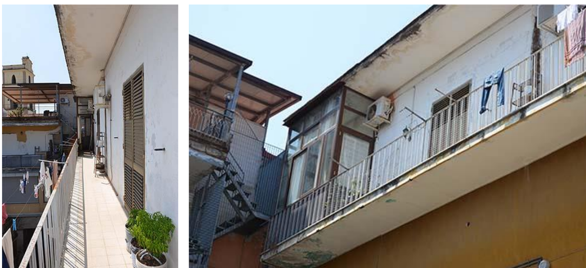
_ballatoio di ingresso
