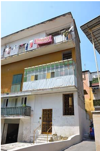
_corpo scala del fabbricato
