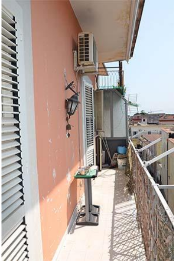
_balcone lato strada
